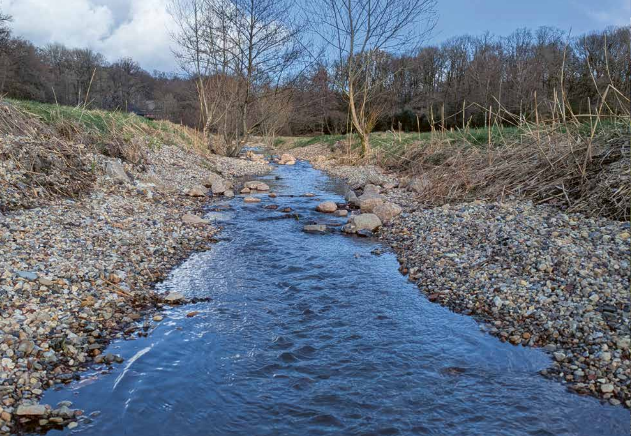
Neue Kiessohle auf einer Länge von 423 m
