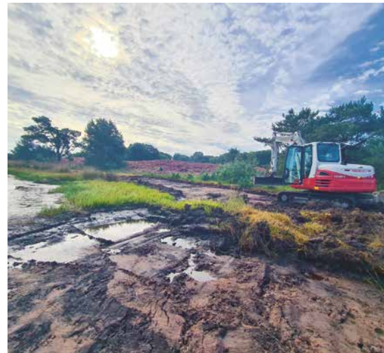
Entschlammung des Preisingleiches
