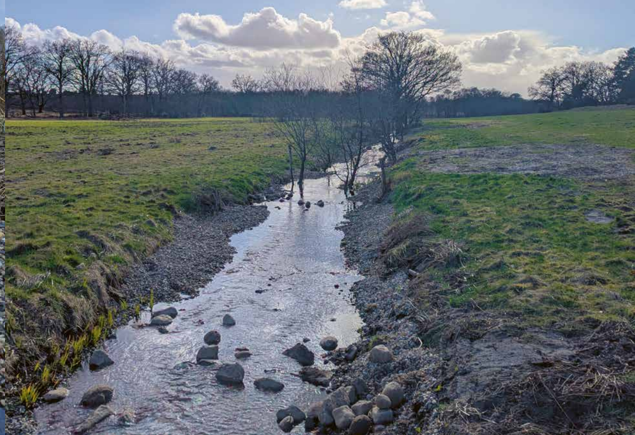
Störsteine und Strömungslenker
