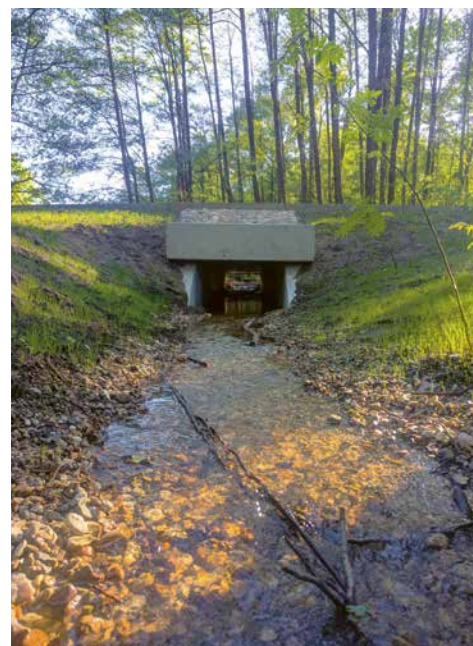
Vorher/Nachher: alter Rohrdurchlass (links), neues Durchlassbauwerk und angehobene Höhenlage der Straße (rechts)
