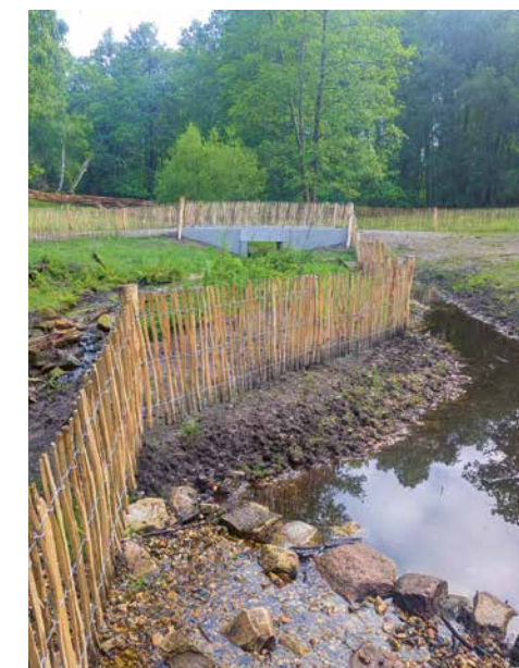
Neue Viehtränke mit Kiesschwelle beim Auslauf, um Sandeintrag in die Haverbeeke zu vermeiden
