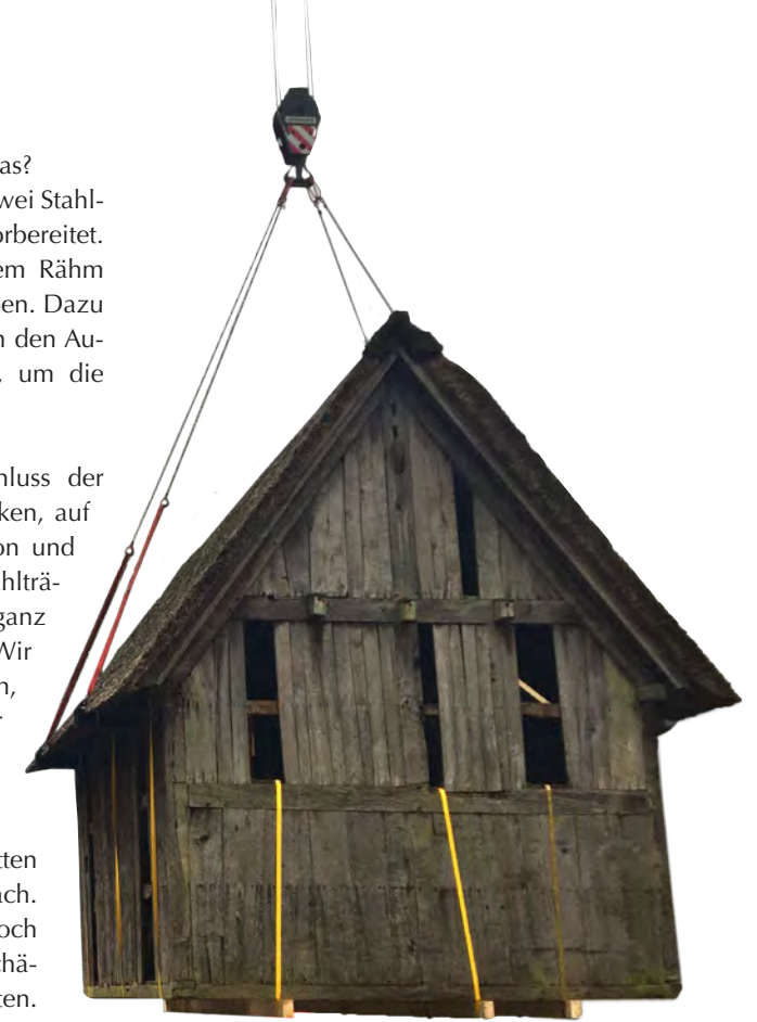
Der Speicher macht sich auf den Weg zu seinem neuen Standort auf dem Schulbauernhof in Wilsede
